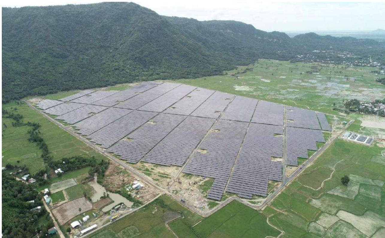
Nhà máy Sao Mai Solar PV1 dưới chân Núi Cẩm tại xã An Hảo, huyện Tịnh Biên, tỉnh An Giang
