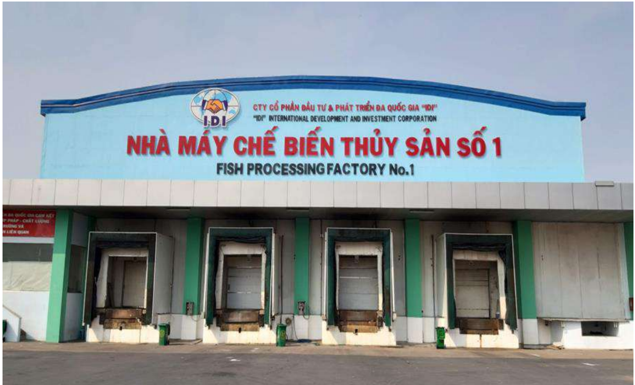
Nhà máy đông lạnh số 1 hoạt động từ năm 2005 với công suất là 300 tấn nguyên liệu/12 giờ/ngày
